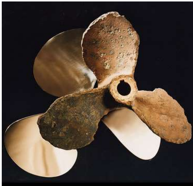
Gambar 1. Korosi pada propeller kapal ( http://mgduff.co.uk/cathodic-protection )
